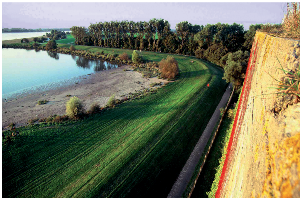
Blick von der Fassade des U-Boot-Bunkers Valentin auf die Flusslandschaft der Unterweser. Foto: Harald Schwörer
