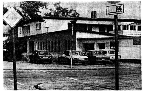
Neues Domizil für die Chemiker der Universität: der ehemalige Coca-Cola-Vertrieb an der Cloppener Straße.
