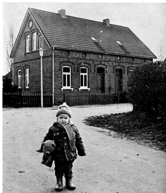
Durch Nichtsanierung zur Abbruchruine? Siedlungshaus der Klävmann-Stiftung Foto: Kurt Oesterling
