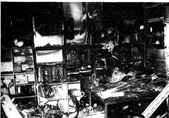
Nicht nur die Installationen und Geräte wurden im Großraumlabor völlig zerstört, sondern auch viele Forschungsunterlagen
