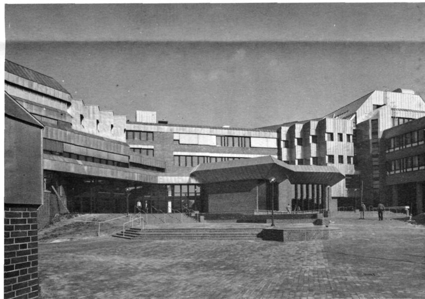
Der Zentralbereich: weit geöffnet zur Stadt
