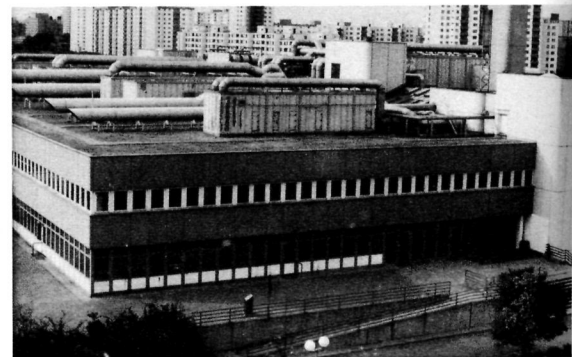
Menschenfeindliche Architektur: Mittelstufenzentrum in Berlin-Neukölln
