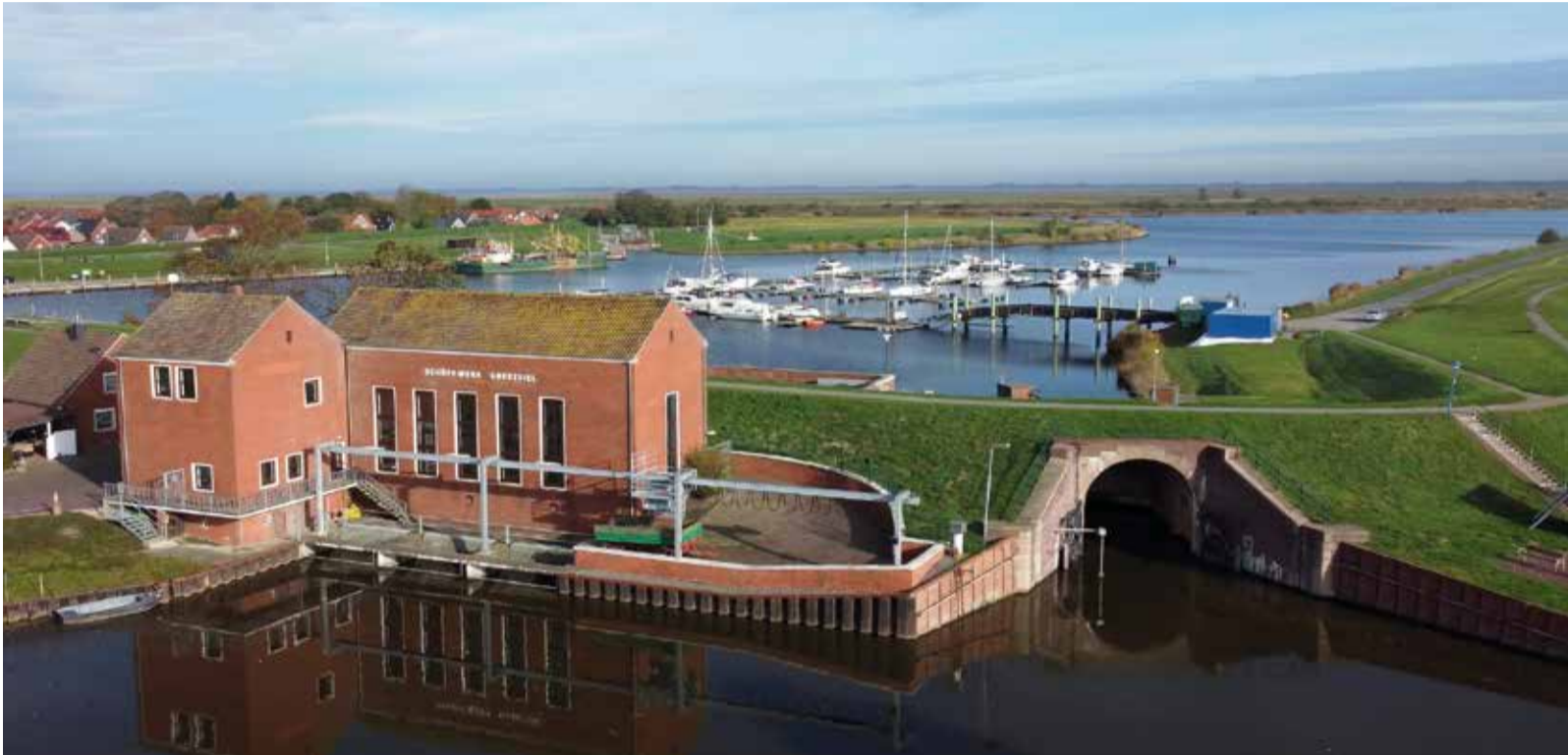
Damit sich das Binnenwasser in Ostfriesland nicht am Deich staut und zu Überflutungen führt, wird es zum Beispiel in Schöpfwerken – wie hier in Greetsiel – in die Nordsee gepumpt. Die durch den Klimawandel steigenden Wassermengen bringen diese Werke aber an einigen Standorten perspektivisch an ihre Leistungsgrenzen. Foto: Jan Spiekermann
