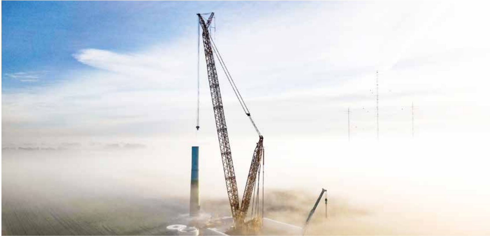
Ein Großkran montierte Stück für Stück die Segmente der großen Windkraftanlagen des Forschungswindparks. Die drei Messmasten im Hintergrund ermöglichen es erstmals, die turbulenten Windverhältnisse zwischen Windturbinen zeitlich und räumlich hochaufgelöst zu messen. Foto: DLR, CC BY-NC-ND 3.0
